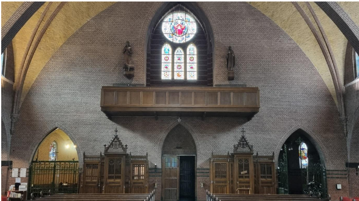
Het verbreed middenschip met een gemetseld bogendak met prachtige bakstenen gewelven
